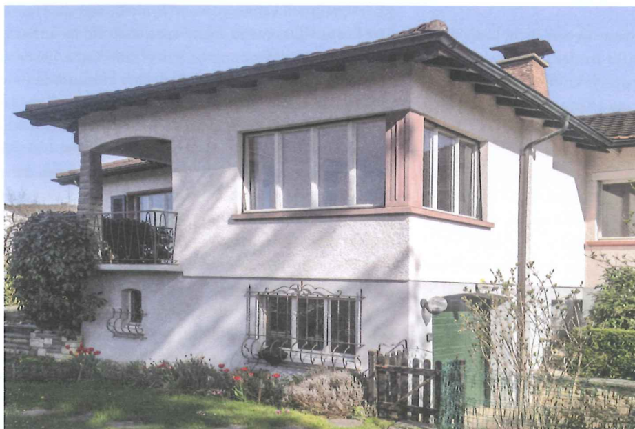
Das Haus vor der Sanierung.
