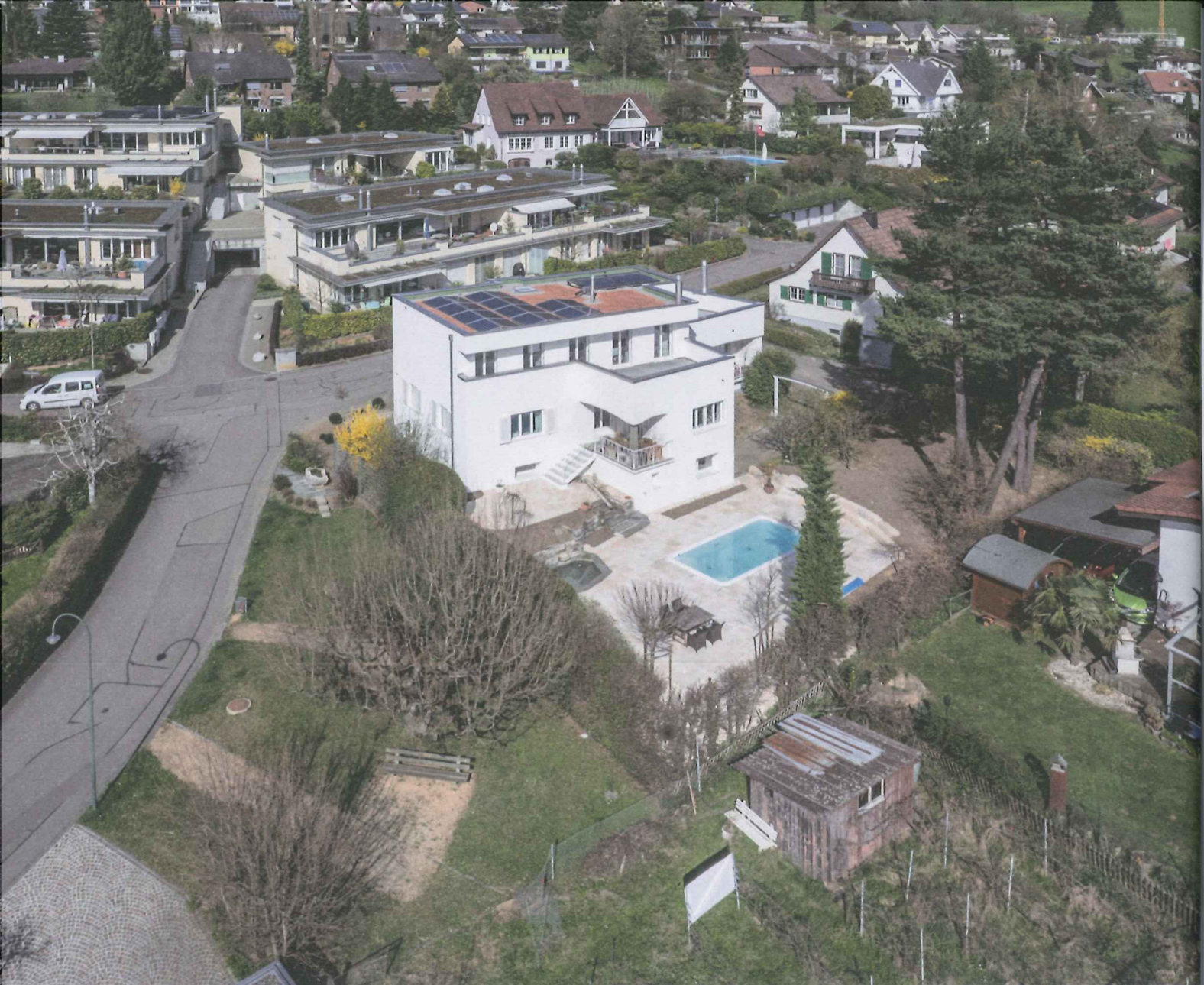
Das aufgestockte und nach Minergie-P sanierte Gebäude. Die Photovoltaikanlage auf dem Dach trägt zum tiefen Energieverbrauch bei.
