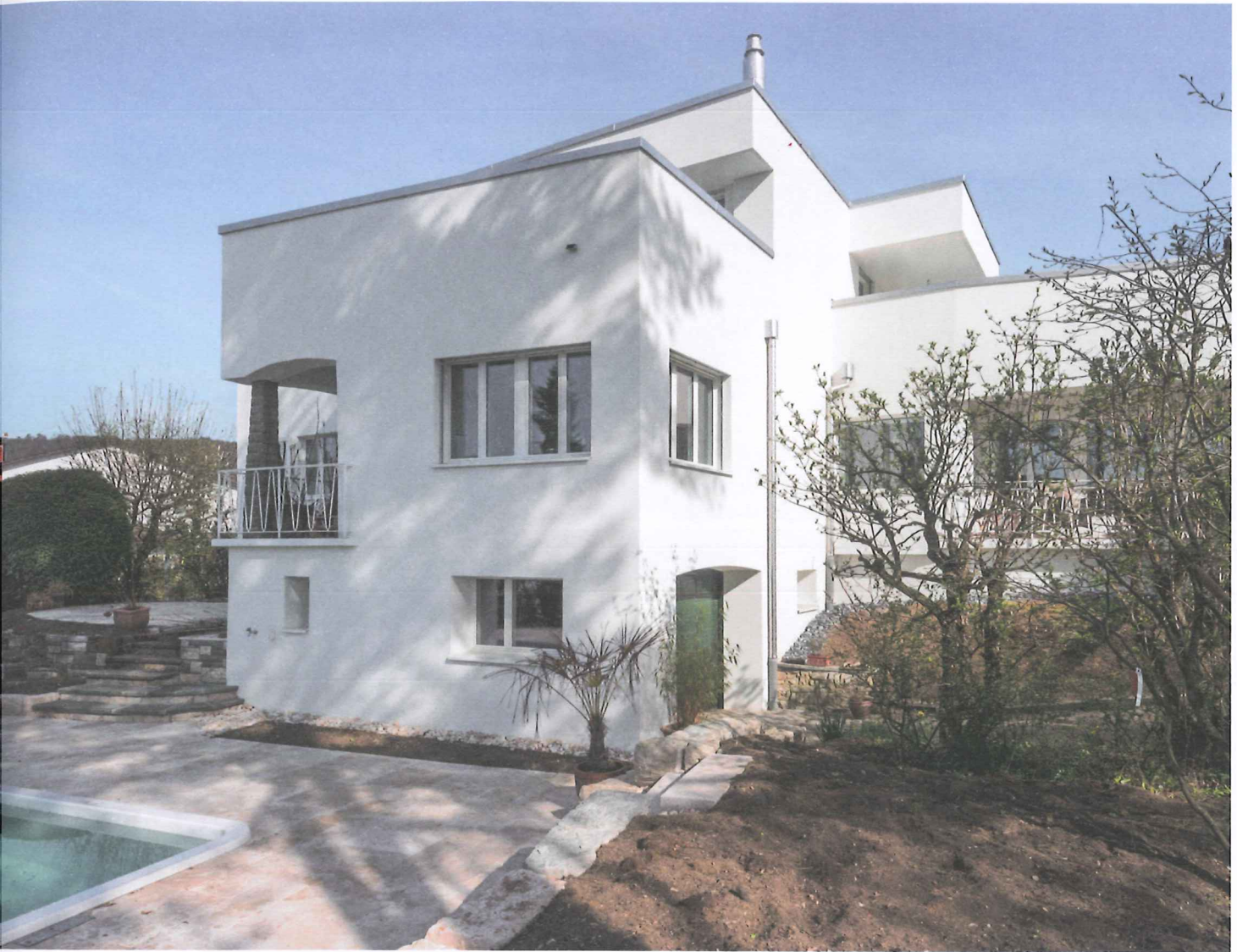
Energetisch saniert und um ein Geschoss aufgestockt: Einige typische Stilelemente wie Säulen und flache Bögen blieben erhalten.
